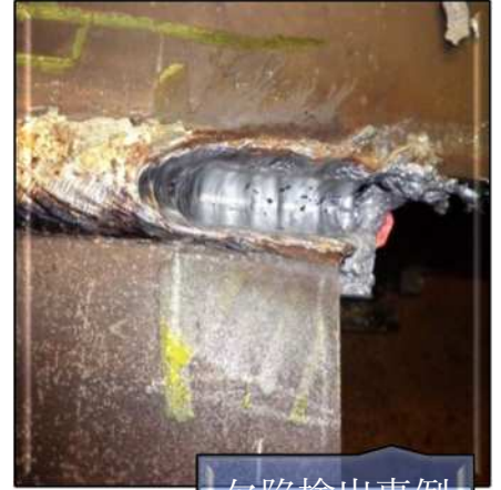
欠陥検出事例
